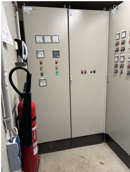
Abbildung 3 Schaltanlage Rechen (Links und Mitte) und Standort Gebäude (Rechts)
