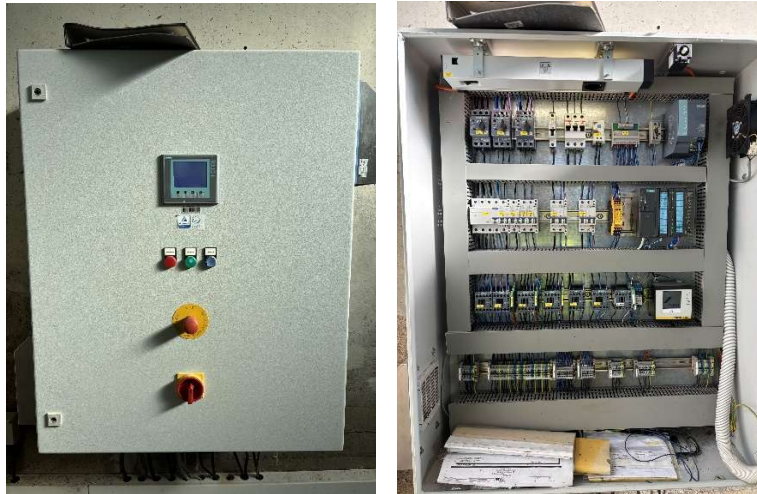
Abbildung 8: Steuerschrank Sandwäscher außen (links) und innen (rechts)
